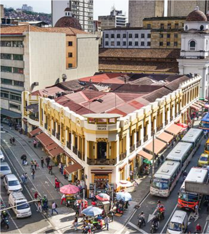
Edificio Constain - Palacé
