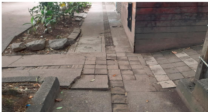
Imagen 14. Estado actual andenes y jardineras
